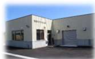
サケふ化施設の稼働開始 （令和4年3月）
