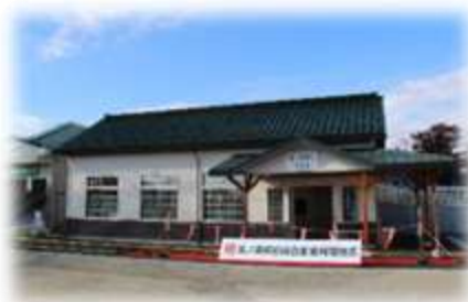
JR夜ノ森駅待合室の 完成（令和2年11月）
