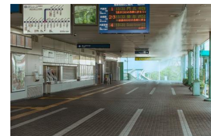
大阪モルルール万博記念公園駅 クールスポット整備事業（吹田市）
