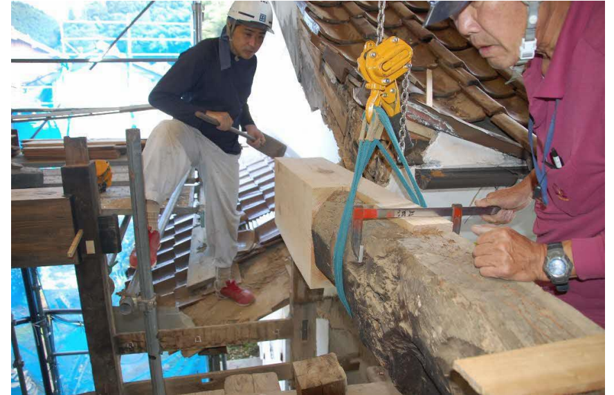
木工事（軸部修理）
