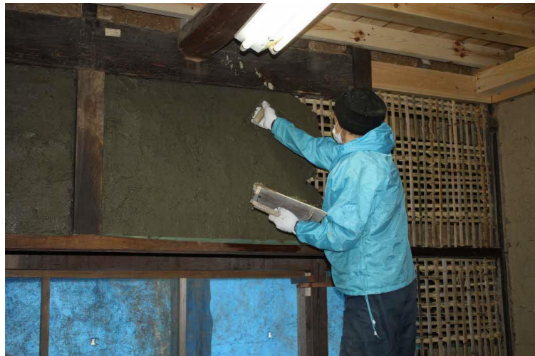
左官工事（土壁塗り）
